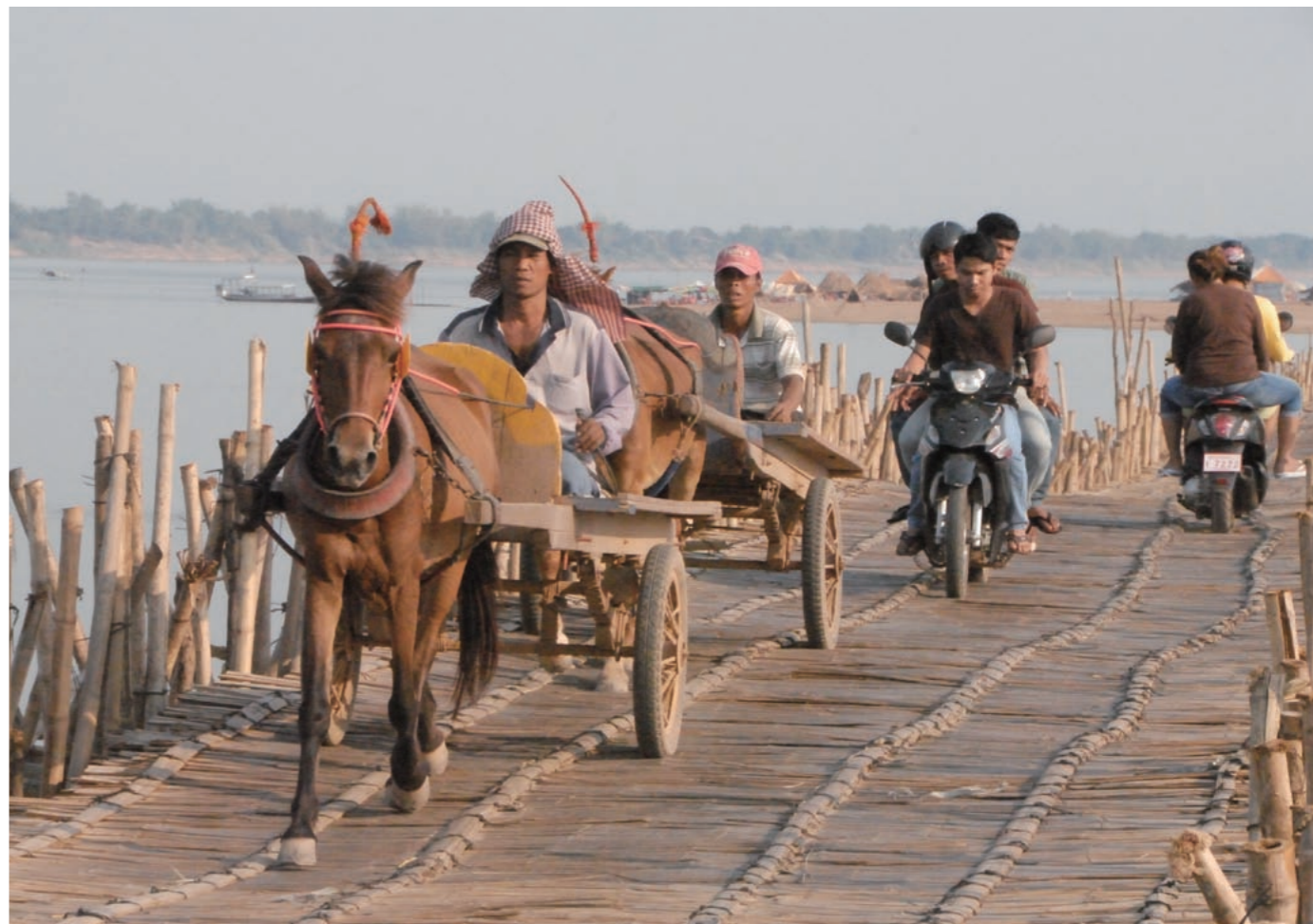
竹だけで造った橋はギンギン音がするが人だけでなく馬車やバイクも渡っていた
